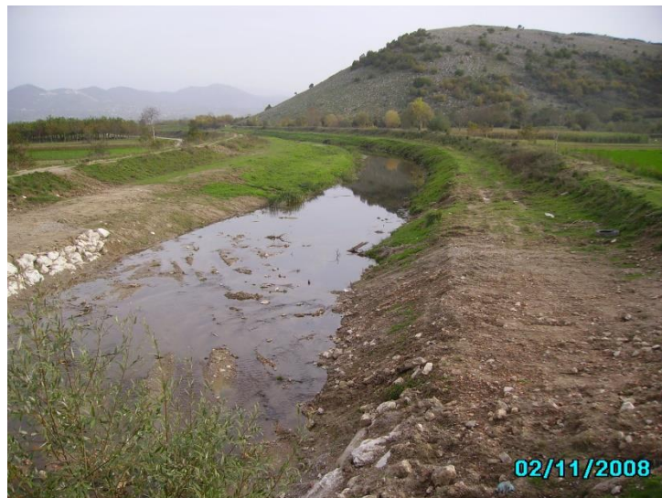
Tratto arginato tra ponte Fornino e briglia sifonata
