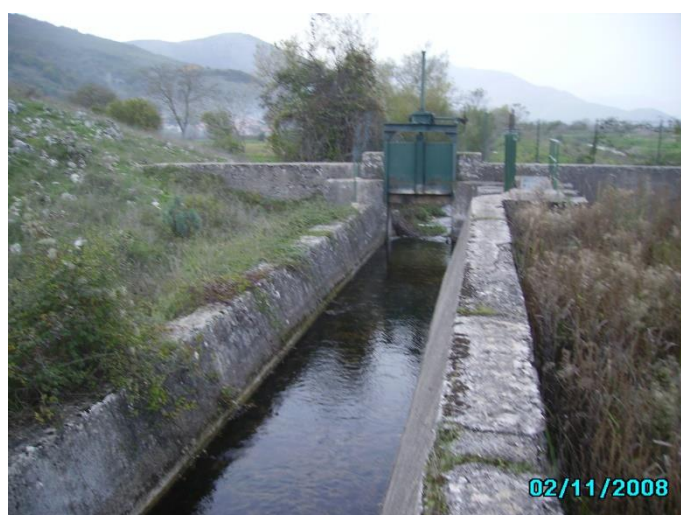
Canale rio freddo tronco in cls, ad uso irriguo e paratoia di manovra sullo sfondo
